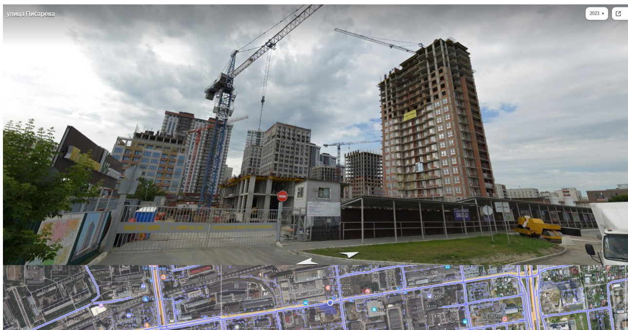
Рисунок 4 Характер окружающей застройки (общий вид ЖК «На Писарева» по состоянию на 2023 год).
