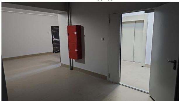
Фото 3. Лестничная площадка 7 этажа
