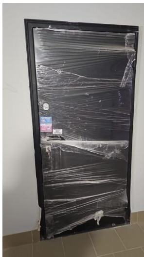
Фото 5. Вход в кв.34
