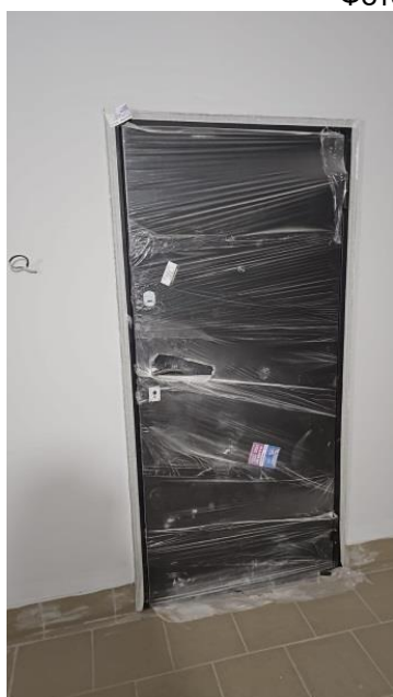
Фото 3. Вход в кв. 66
