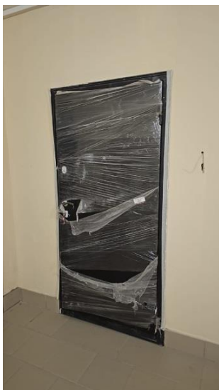
Фото 1. Вход в кв.118
