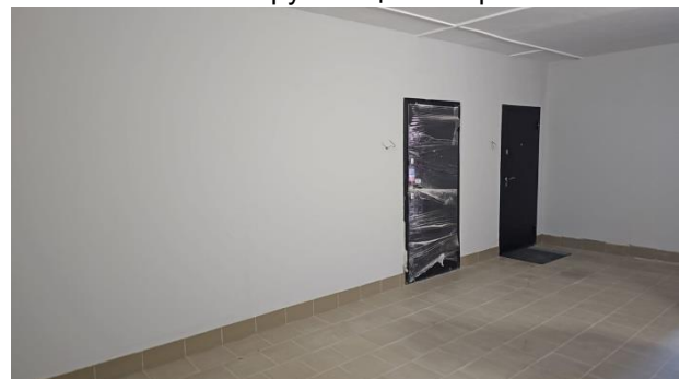
Фото 4. Лестничная площадка 7 этажа
