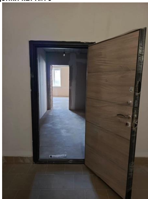
Фото 1-2. Вход в кв.70
