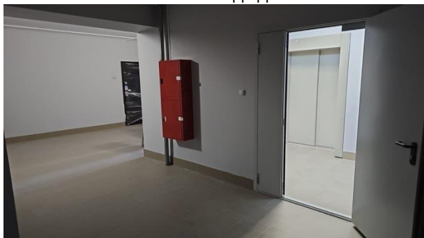
Фото 3. Лестничная площадка 7 этажа
