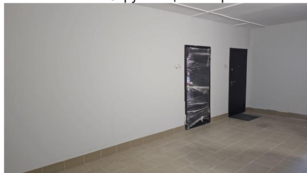
Фото 4. Лестничная площадка 7 этажа
