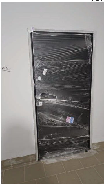
Фото 3. Вход в кв. 66
