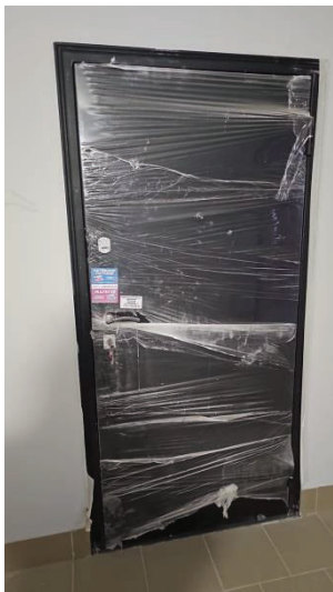
Фото 5. Вход в кв.34
