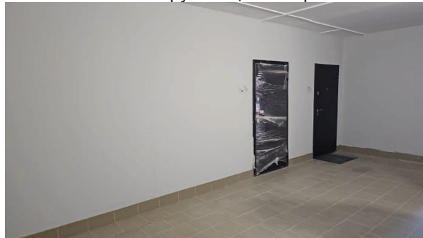
Фото 4. Лестничная площадка 7 этажа
