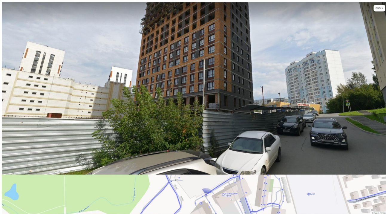
Рисунок 3 Характер окружающей застройки.
